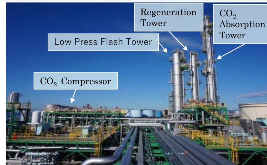
苫小牧CCS設備の外観
