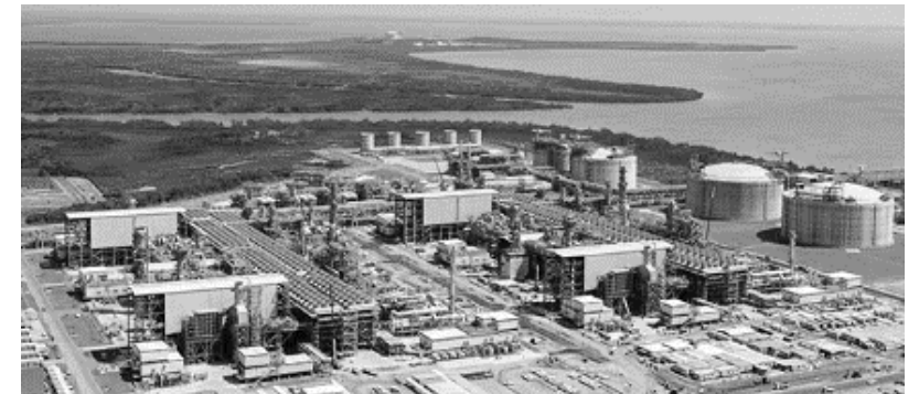
Ichthys LNG Plant @ Darwin, AUS
